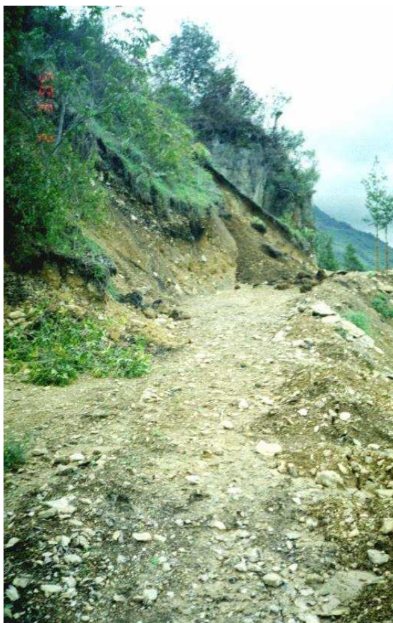
Deslizamiento en la vía Puerto valencia - Topa
