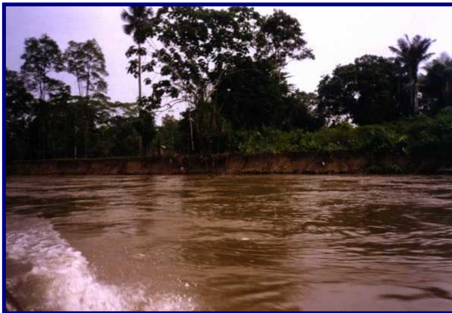
Foto 8. Inestabilidad de los suelos adyacentes a los cauces de los ríos, desprendimiento en los talues. Procesos de erosión en masa a orillas del río Congor (foto Carlos A Gómez).
