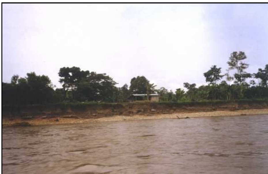
Foto 9. Desprendimientos de talud a orillas del río Caquetá ocasionando pérdidas de cultivos, ganado y viviendas (foto Carlos A Gómez).
