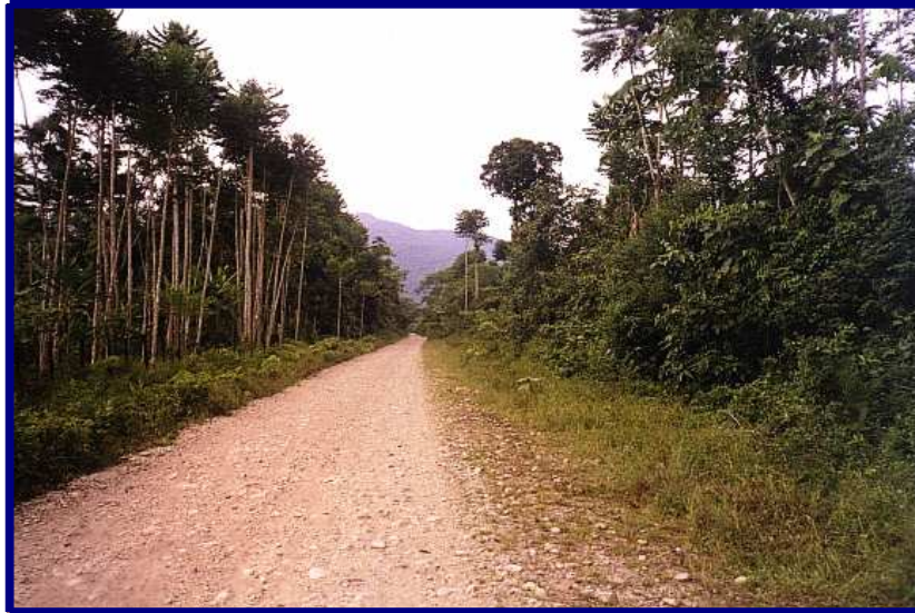
Foto 7. Vía construida por la Compañía Petrolera Argosy. (foto Rodrigo Gómez).
