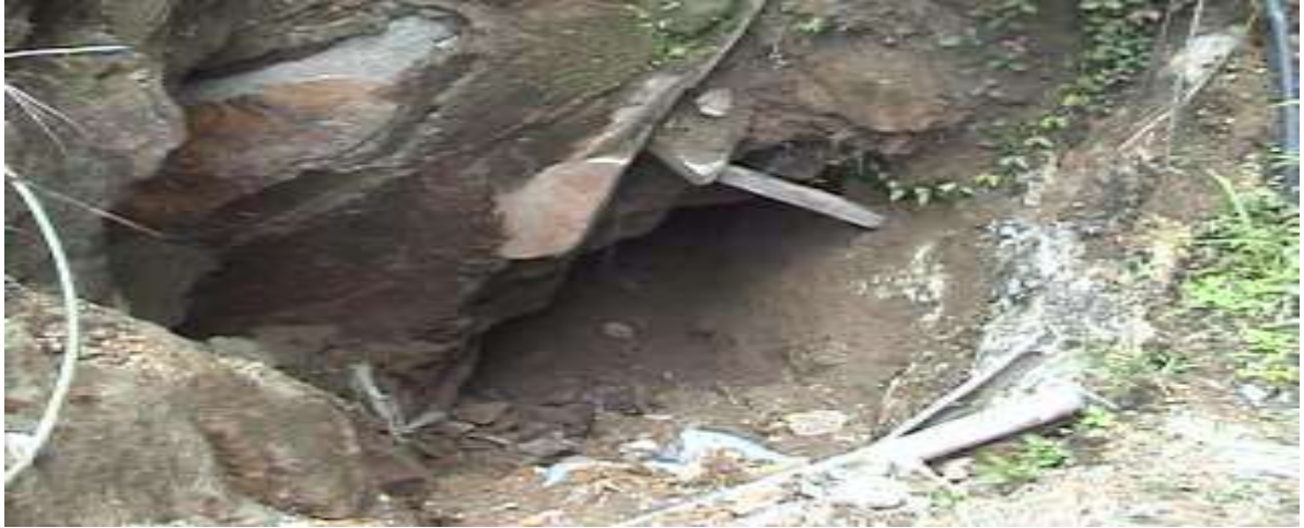
Foto No 07 sostenimiento natural en una clavada.
