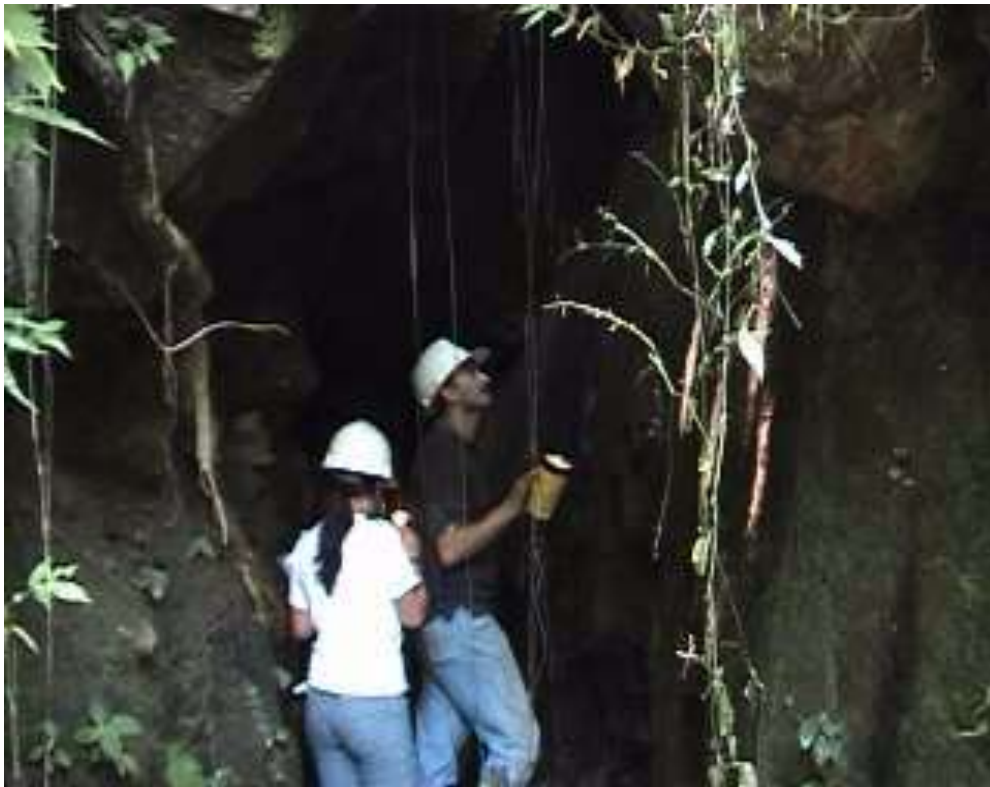
Foto No 05 Sostenimiento natural en roca diaclazada.
