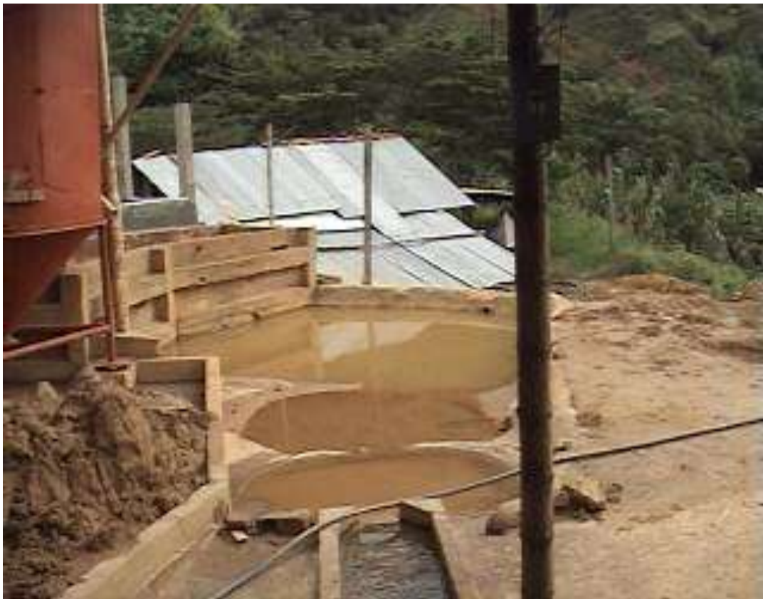
Foto No 39 tanques sedimentadores de arenas y lodos Serví minas.
