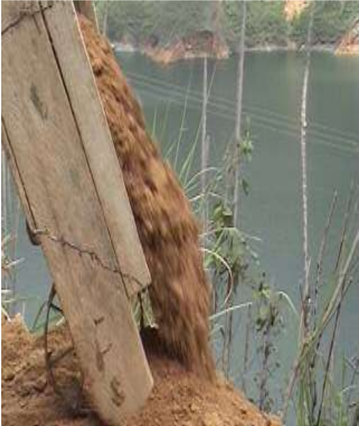
Foto No 15 descargue material estéril sobre la pendiente de la colina.
