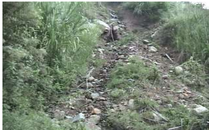
FOTO No 02. PERDIDA DE COBERTURA VEGETAL Y CONTAMINACIÓN VISUAL.
